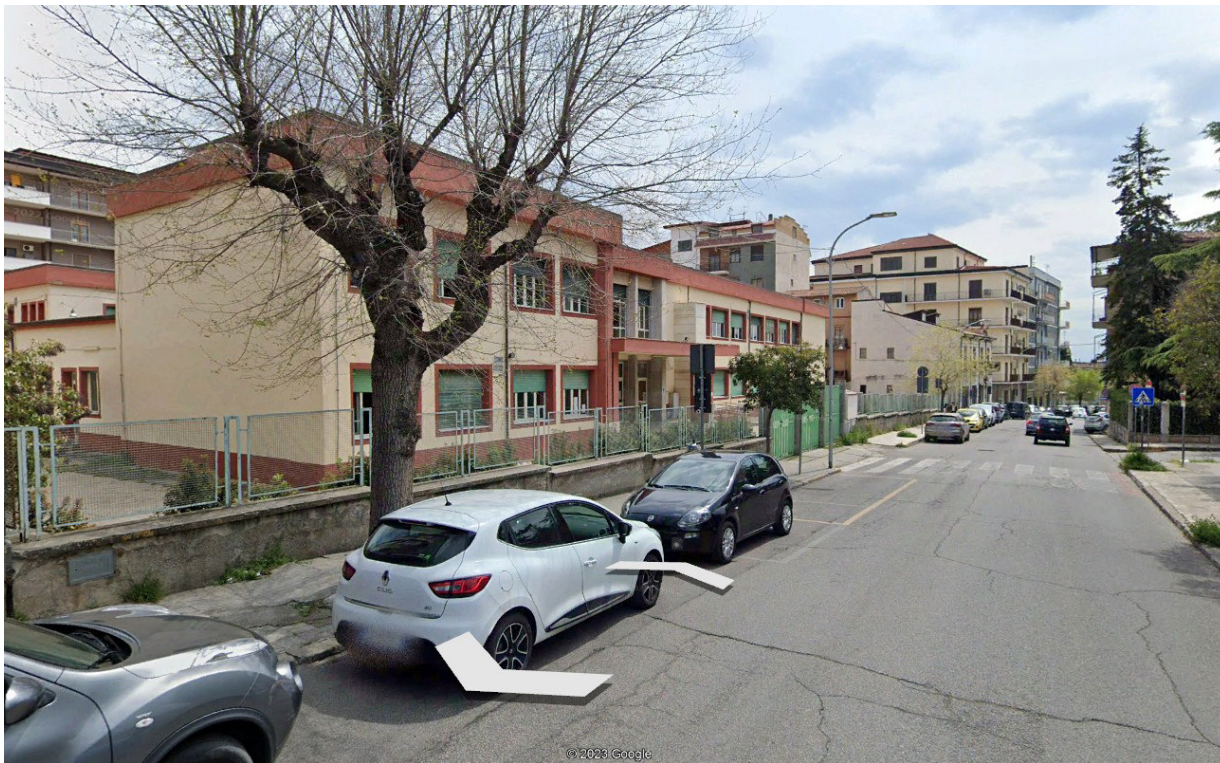
VISTA FRONTE STRADA
