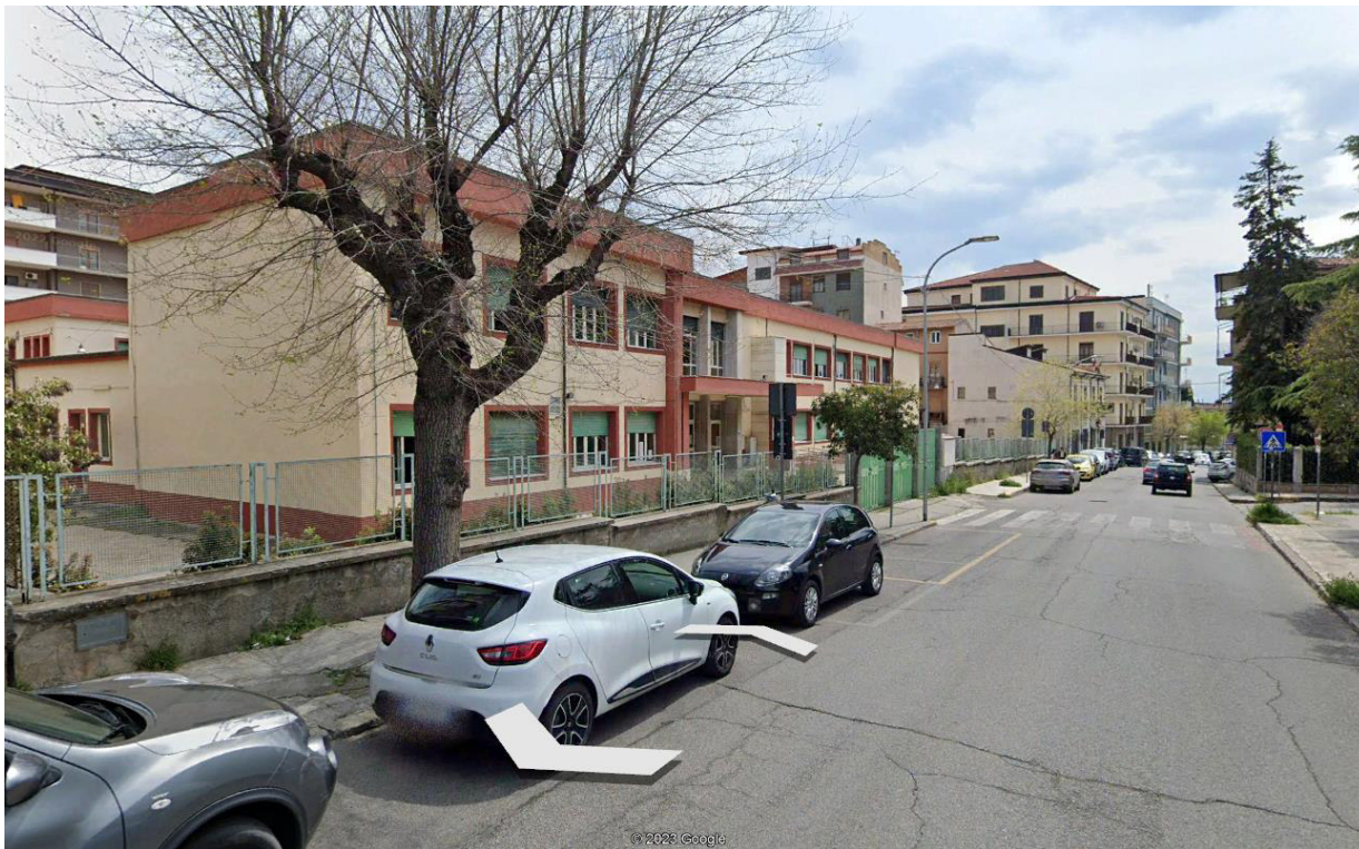
VISTA FRONTE STRADA
